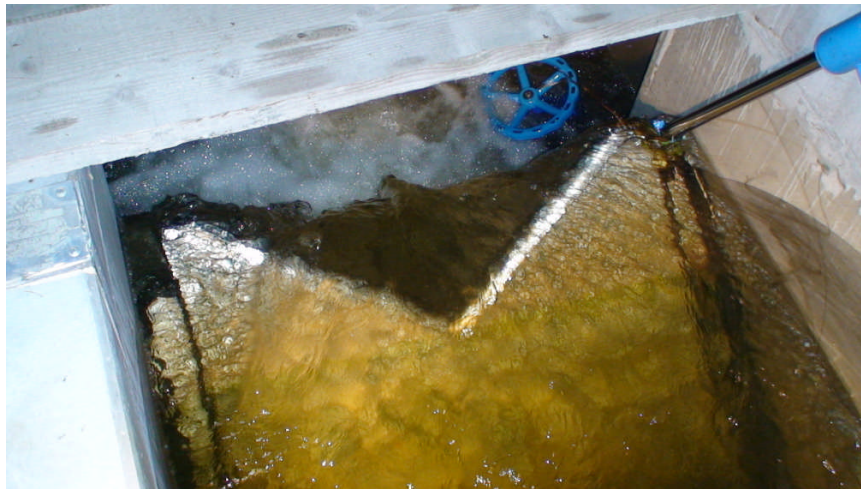
Abbildung 9: Starke und abrupte Zunahme der Fließgeschwindigkeit in der V-förmigen Kerbe (Bündelung des Wasserstrahls, die Fließgeschwindigkeit nimmt auf einer Strecke von ca. 0,8 m um über 1,5 m/s zu)
