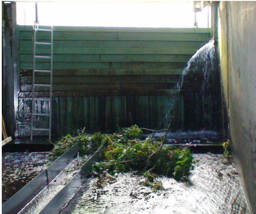
Abbildung 10: Eine mit Geäst verlegte Abstiegsrinne verhindert die schadhlose Rückführung von Fischen in das Unterwasser
