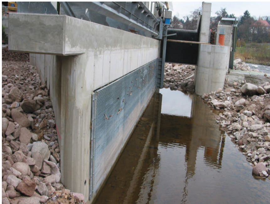
Abbildung 5: Anlage „Klingelmühle“ in der Bauphase, Blickrichtung gewässerabwärts: schräg angeordneter Horizontalrechen mit Bypassöffnung im spitzen Winkel;
